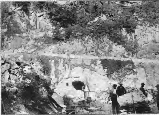
Fig. 4. Tunnelanfang und Achspunkt auf der Südseite. Portal des Richtstellens bei Isella.
